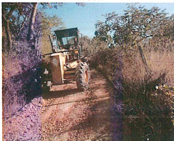
CAMINO JUNTAS DEL SUR
