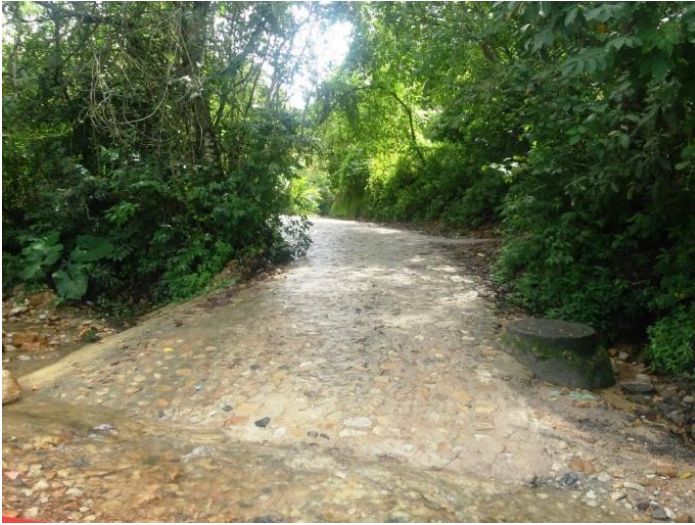
(Empedrado ahogado en cemento, colonia Las Moradas, El Tuito)
