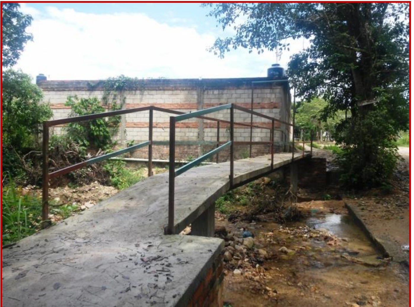
(Puente peatonal en Colonia Las Moradas de El Tuito)
