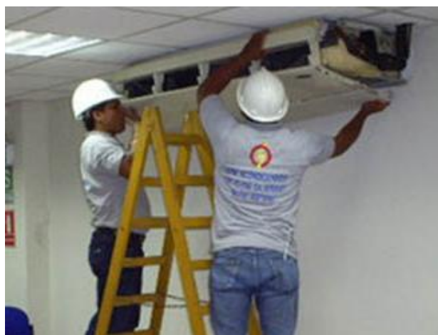
(Instalación de aires acondicionados en Mayto)
