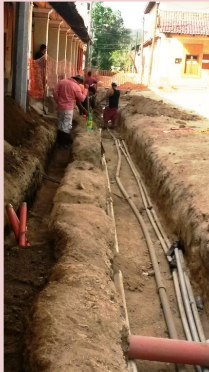
(Tubería y descargas domiciliarias)
