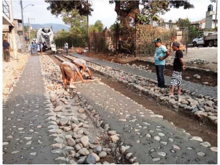
Calle Pablo Ríos en El Tuito
