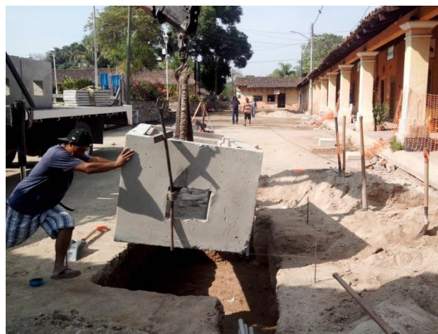
Cableado subterráneo CFE y TELMEX
