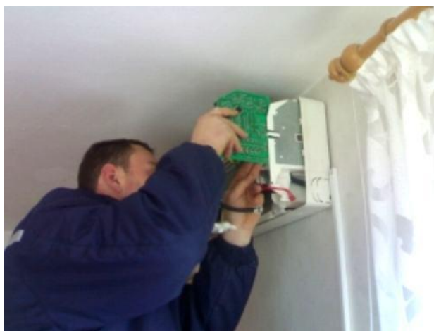
(Instalación de aires acondicionados en Mayto)
