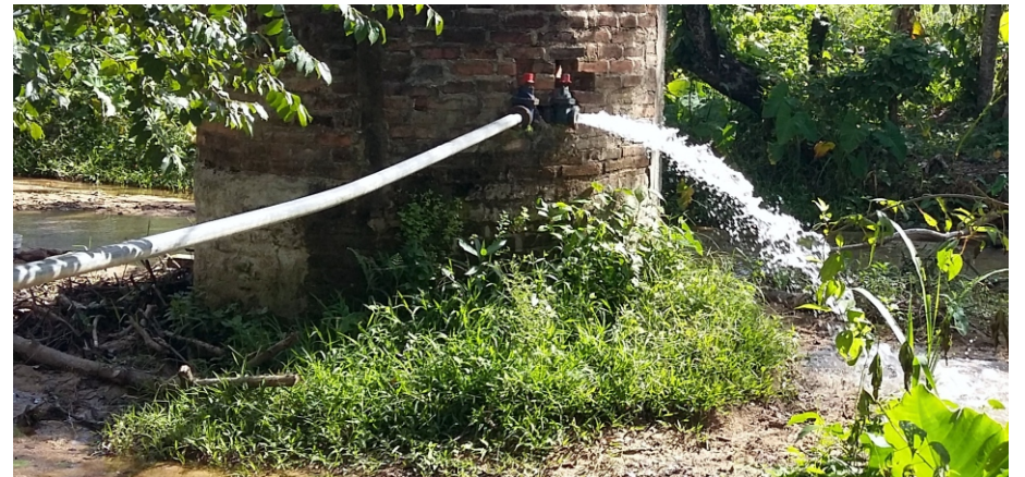
Rehabilitación del servicio de agua potable en la localidad de Paulo
