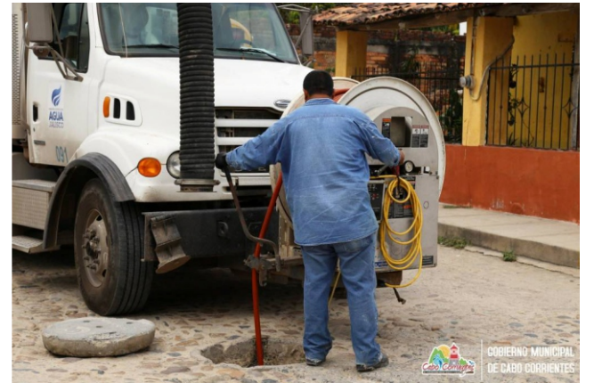
Desazolve y limpieza de drenaje con equipo vector
