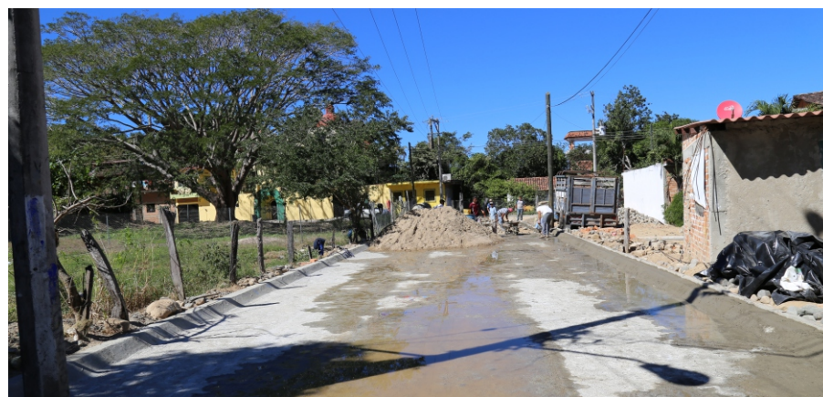
Construcción de línea de agua potable, drenaje y empedrado ahogado en cemento andador Moises
