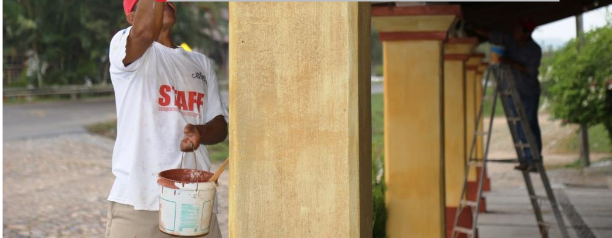
Mantenimiento con pintura en los portales de ingreso a El Tuito
