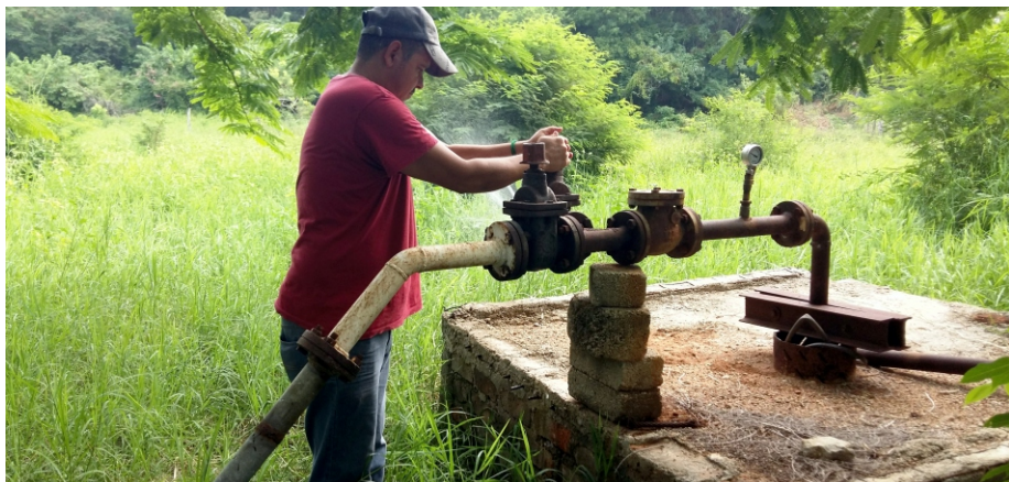
Habilitación del servicio de agua potable en la localidad de Playitas
