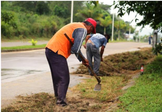
Limpieza en avenida de ingreso La Hacienda
