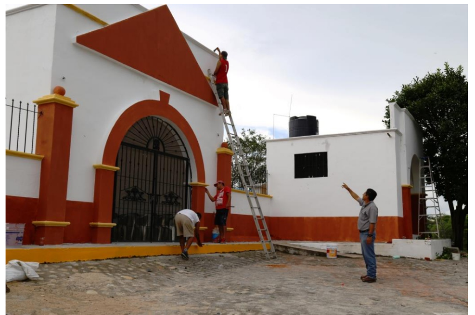
Obras de mantenimiento en panteón municipal El Tuito
