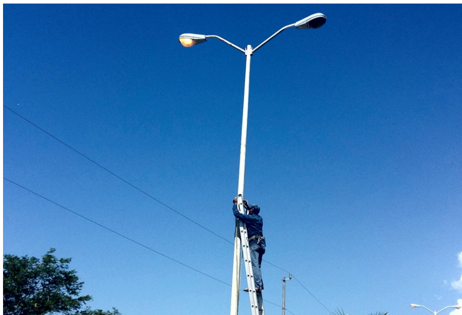
Rehabilitación alumbrado público en Av. de ingreso La Hacienda
