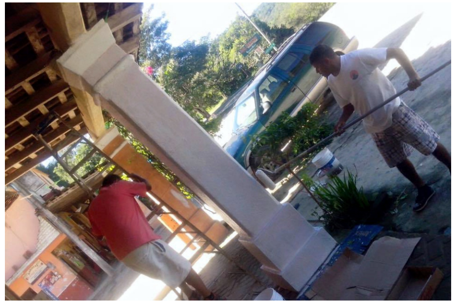
Mantenimiento y pintura a portales de Las Juntas y Veranos
